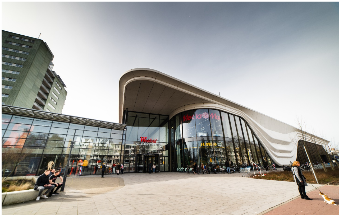
Obrázek 1: Projekt rekonstrukce obchodního centra Westfield Mall of the Netherlands zadala developerská společnost Unibail Rodamco Westfield s cílem vytvořit novou nizozemskou nákupní, gastronomickou a zábavní destinaci (zdroj: Hueck)
