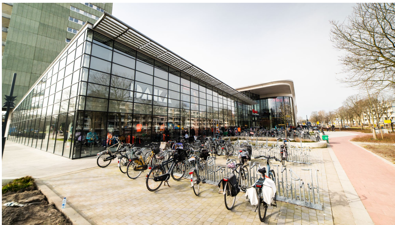
Obrázek 2: Konstrukce nákupního centra je založena na kombinaci prvků fasádního systému HUECK Trigon 50 s integrovanými dveřními řešeními HUECK Lambda DS 075 (zdroj: HUECK)
