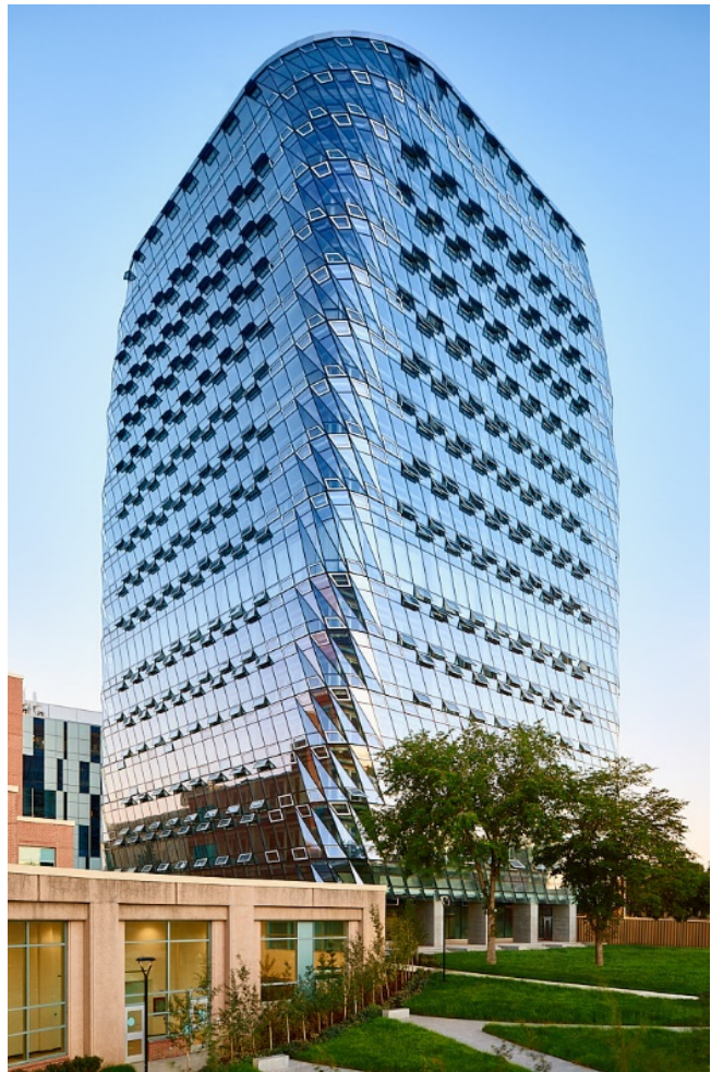
Afbeelding 2: De MacKimmie Tower is voorzien van een dubbelwandige 'ademende' gevel die zeer efficiënt energiegebruik, continue ventilatie en hoogwaardige binnenverlichting mogelijk maakt (bron: Hueck)
